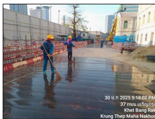
ภาพที่ 6 กวาดฝุ่นละอองและตะกอนภายหลังการฉีดพรมน้ำ
