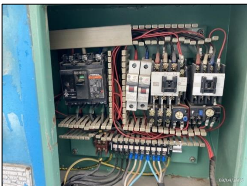
ภาพที่ 50 ติดตั้งแผงควบคุมไฟฟ้าและเครื่องตัด กระแสไฟฟ้า
